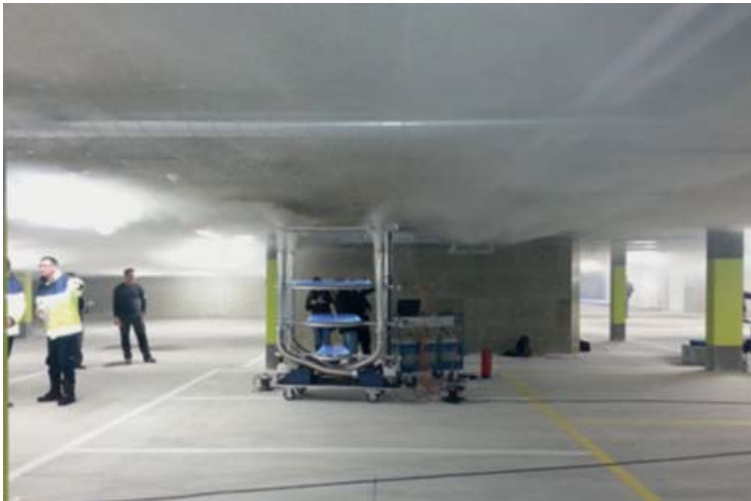
Abb. 2: Rauchversuch als Nachweis der Erfüllung bauordnungsrechtlicher Schutzziele
