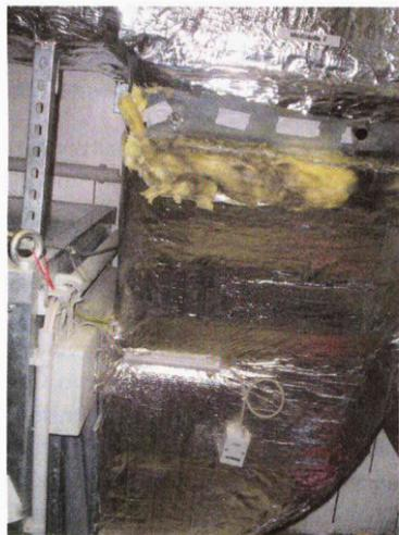
**Diese Messstelle 7, direkt nach den Druckstutzen des Ventilators, ist unbrauchbar. Leider sind solche Messstellen oft vorzufinden, die Protokolle dieser Firmen sind nichts wert.**
