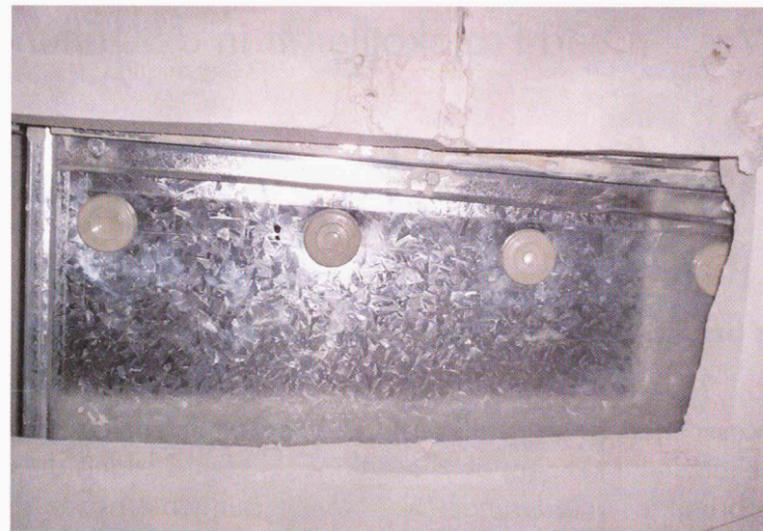
Die Verkleidung des Luftkanals erlaubt keine ordentliche Messung der Luftmenge. Hier kann keine richtige Messung nach Fertigstellung der Anlage stattgefunden haben.
